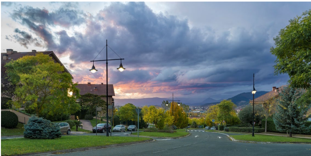
Luminarias instaladas en Gorraiz Foto cortesía de ATP Iluminación
